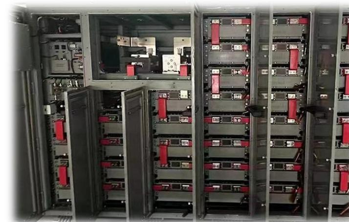
Система из последовательно соединенных модулей до напряжения 4400 В
